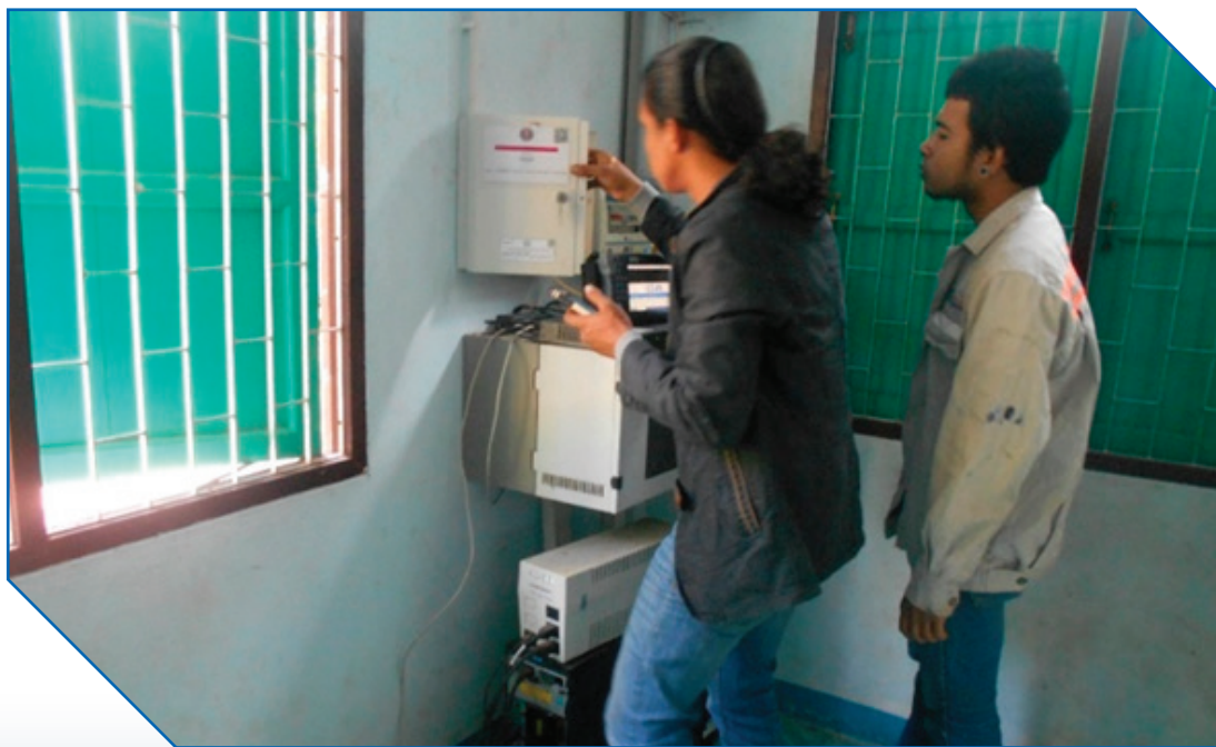
ภาพ การซ่อมแซม ตรวจสอบระบบ Internet ของโรงเรียนให้ใช้งานได้เป็นปัจจุบัน
